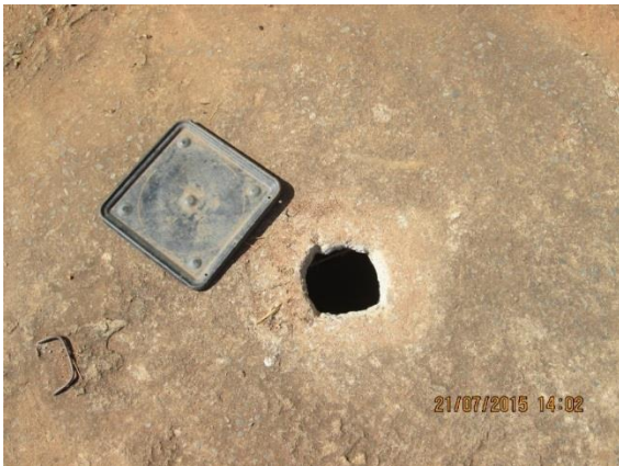
Figura 42 – Fossa rudimentar na calçada, Bairro Novo Igarapé
