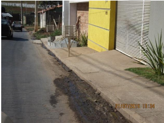
Figura 44 – Esgoto doméstico lançado a céu aberto, Bairro Novo Igarapé Fonte: Projeta Engenharia (2015)
