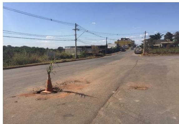
Figura 68 - Área de inundação em frente à antiga rodoviária
