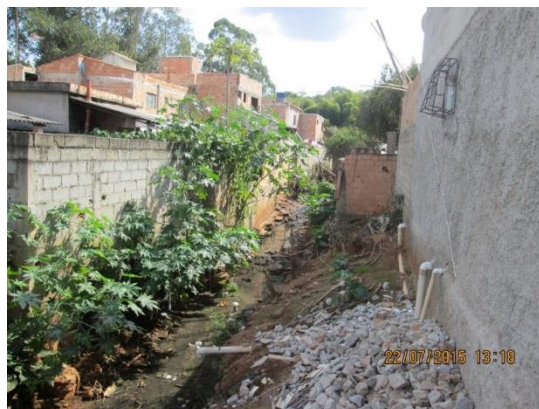
Figura 50 – Lançamento individual direto no manancial, bairro Vila Madalena
