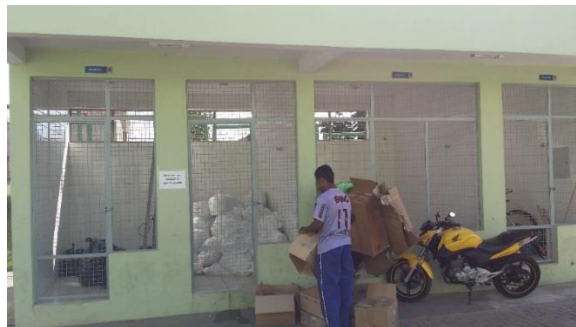
Figura 94– Abrigo utilizado para armazenamento das bombonas contendo RSS - UPA Fonte: Projeta Engenharia (2015)
