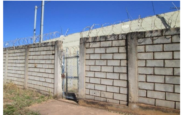
Figura 29 – Reservatório apoiado Pousada Del Rey
