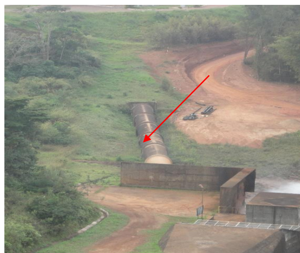
Figura 5 – Adutora de água bruta
