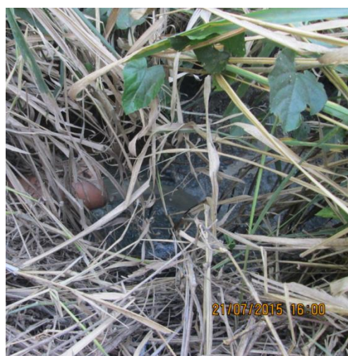
Figura 35 - Lançamento do interceptor no Córrego Machado - Bairro Progresso
