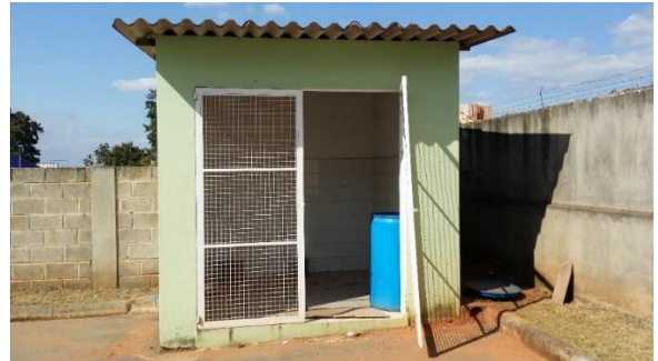
Figura 93 – Abrigo utilizado para armazenamento das bombonas contendo RSS - UBS José Lopes Carvalho Fonte: Projeta Engenharia (2015)
