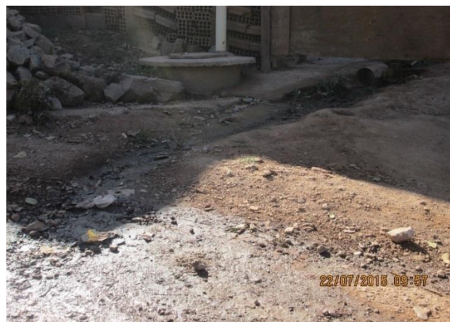
Figura 48 – Esgoto de cozinha lançado a céu aberto e fossa rudimentar ao fundo, Bairro Jequitibá
