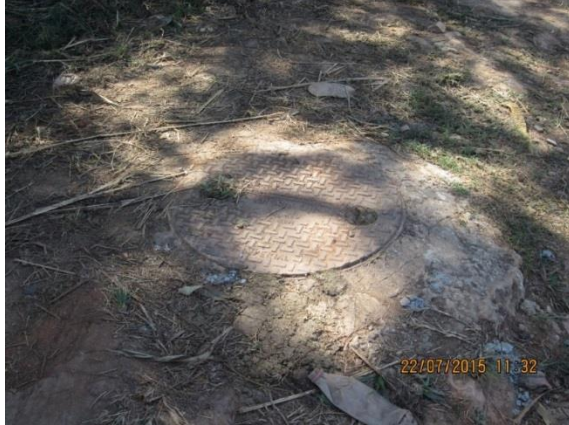
Figura 36 – Poço de visita do 1º Interceptor do Córrego Fundo Fonte: Projeta Engenharia (2015)
