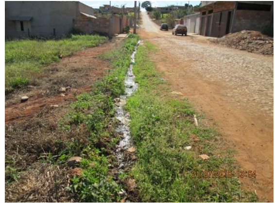
Figura 45 – Esgoto doméstico lançado a céu aberto, Bairro Novo Igarapé Fonte: Projeta Engenharia (2015)
