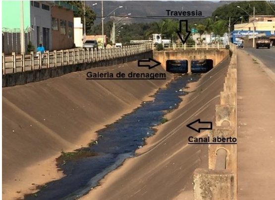
Figura 59: Galeria de drenagem, canal aberto e travessia bairro Santa Monica e Vale do Amanhecer
