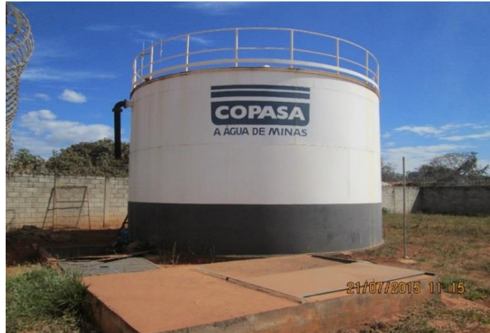
Figura 31 – Reservatório Panorama Industrial
