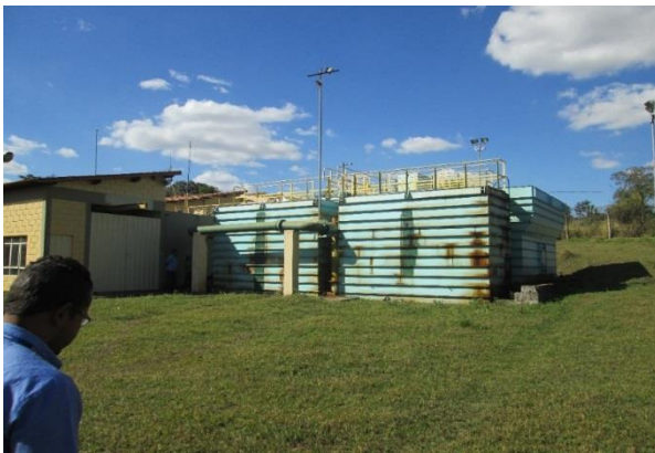
Figura 21 – Vista geral da ETA Fonte: Projeta Engenharia (2015)
