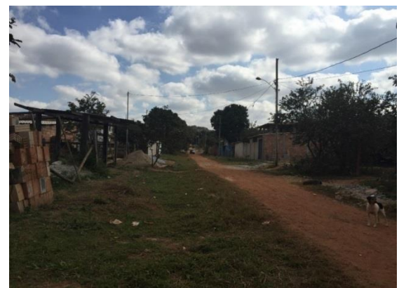
Figura 72 - Área de alagamento - Rua Serro, Bairro Jequitibá
