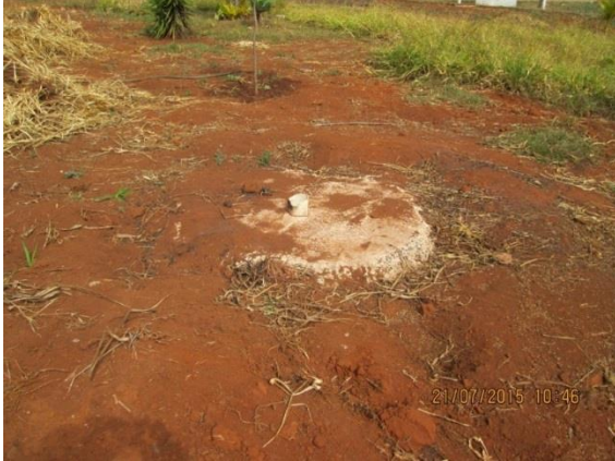
Figura 40 – Fossa rudimentar no Bairro Santa Mônica I
