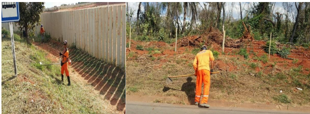
Figura 84 – Realização do serviço de roçada e capina
