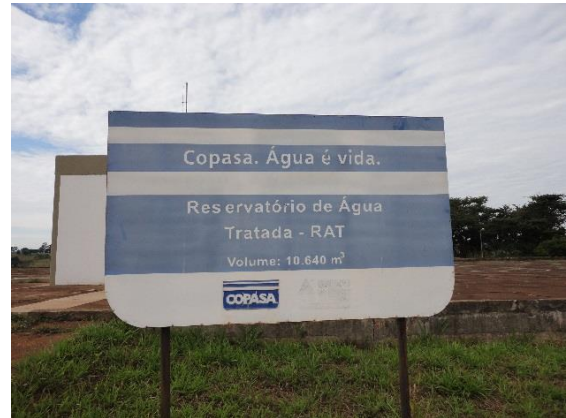
Figura 12 – Reservatório de água tratada
