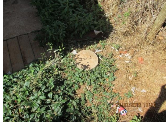
Figura 41 – Fossa rudimentar no Bairro Fazenda dos Mirantes
